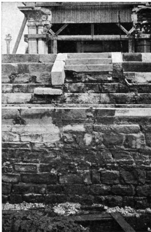
Fig. II — La scala d'accesso al Campanile e la sottostante lesione — Marzo 1903.
