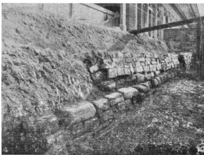
FIG. XI — Antica fondazione abbandonata, parallela alla testata della Libreria.
