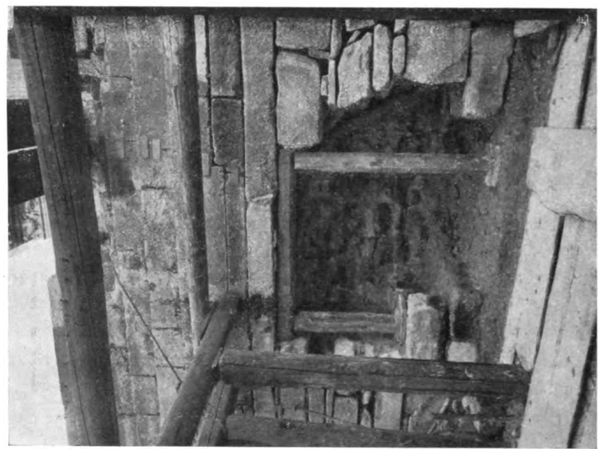
FIG. XIII — Esplorazione del masso di fondazione nel lato nord Maggio 1903.
