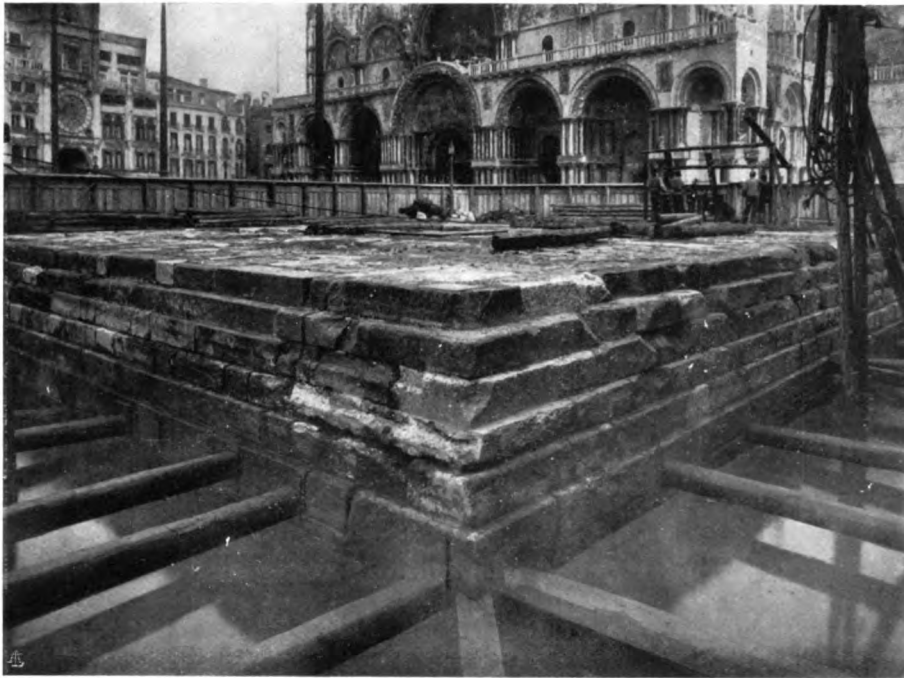
Il lavoro di rinforzo attorno alla vecchia fondazione.
