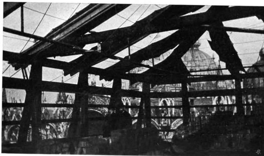
Il lavoro sotto la protezione dell'armatura mobile.
