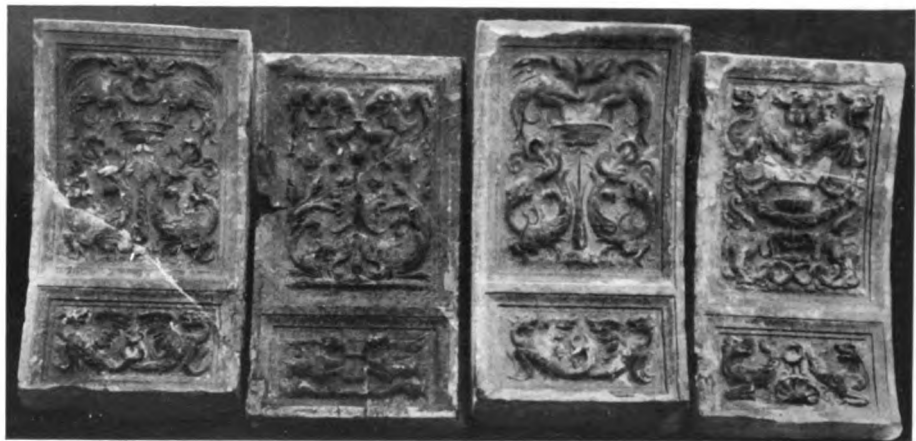
Formelle degli intradossi delle arcate riposte in opera nelle nuove strutture.
