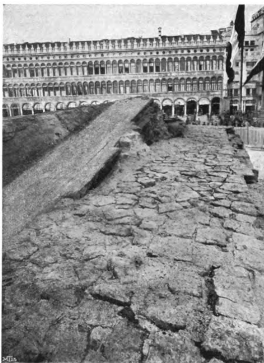
FIG. XVI — Veduta di uno dei corsi di mattoni romani, in prossimità del basamento, e di una delle rampe.
