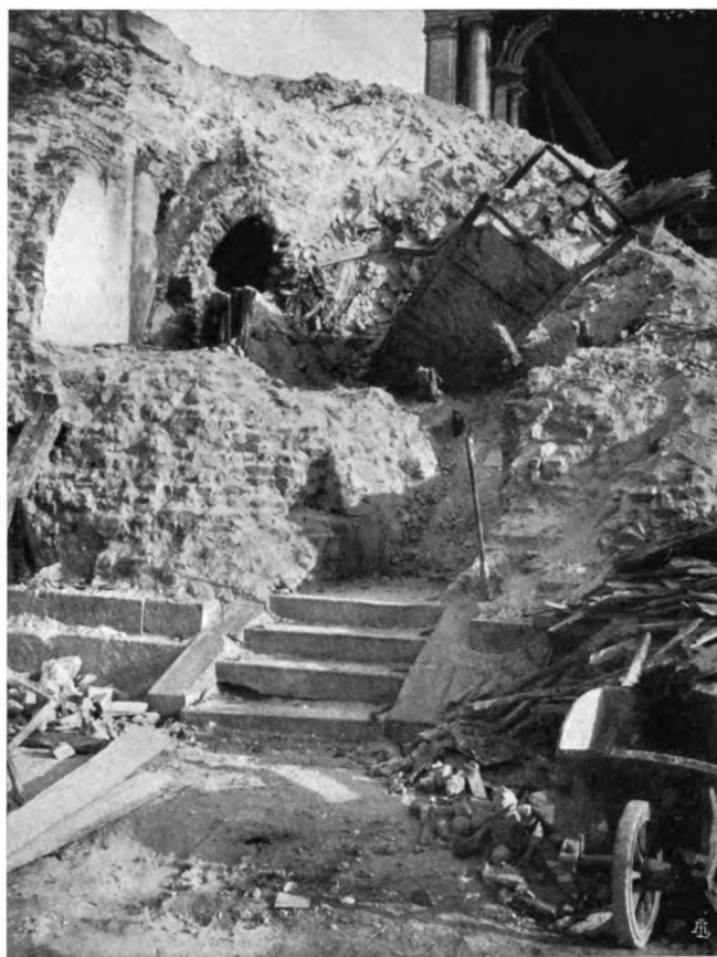
FIG. XVII — Il pilone fasciato di ferro, trovato alla base delle macerie.
