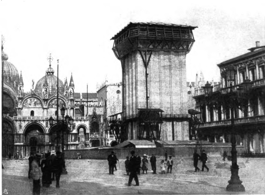
La ricostruzione: l'armatura mobile.
