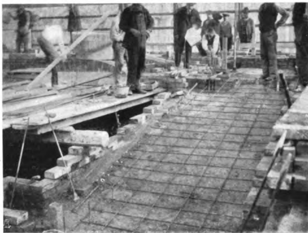
La struttura in cemento armato delle rampe.
